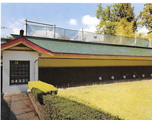
弓道場壁部塗装及び雨樋補強
